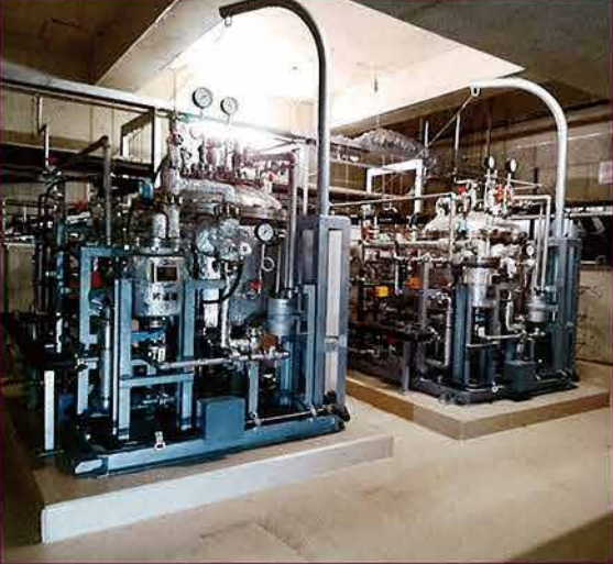
省エネ型連続式加熱滅菌装置 SRAX(南診療棟)
