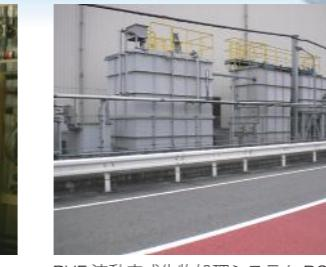
PUF 流動床式生物処理システム BGS
